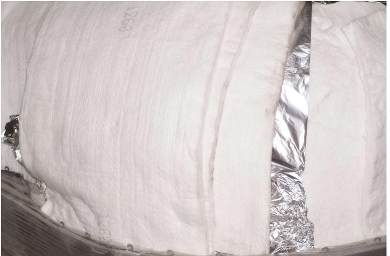
24. Надеть на патрубок сверху защитный термоизоляционный слой "трубной" керамоплиты (теплоизоляционной плиты), саморезами прикрепить к ней «фасадную» теплоизоляционную плиту.
