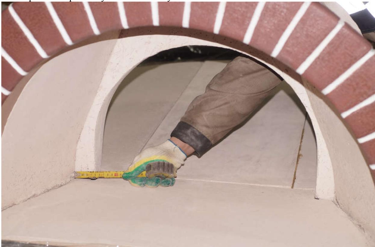
19. Установить сектора печи согласно нумерации, при установке секторов сквозные зазоры не допускаются.
