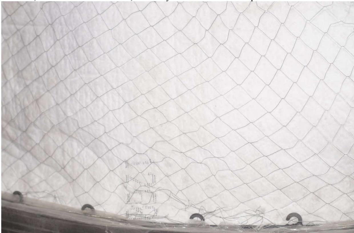
27. С помощью проволоки пропускаемой через кольца по периметру столешницы притянуть крест-на-крест теплоизоляцию и штукатурную сетку к основанию печи, придав печи геометрически правильную форму.
