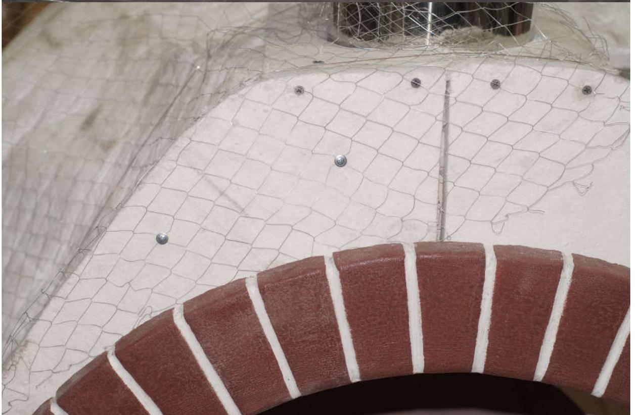
28. Подготовить штукатурный раствор: добавив в воду полипропиленовую фибру, перемешав и всыпав цементно-песчанную смесь, размешав бетономешалкой, до состояния «густой сметаны». Нанести шпателем поверх штукатурной сетки, толщиной до 1 см, придавая печи нужную форму, начиная с лицевой, фасадной стороны печи. Дать высохнуть.
