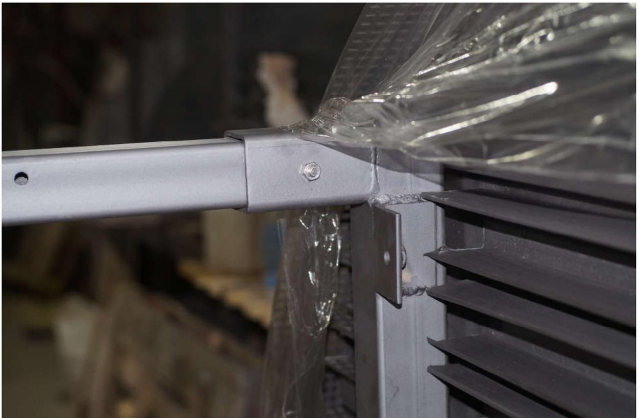
4. Установить укосины согласно меткам и затянуть болтами М8\*60.
